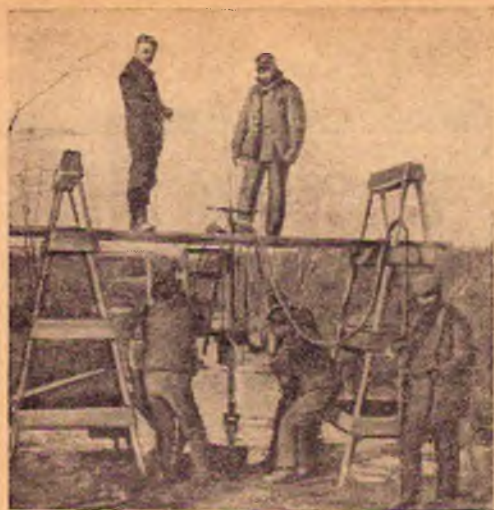
Рис. 2. Вбивание в грунт насоса Нортон
