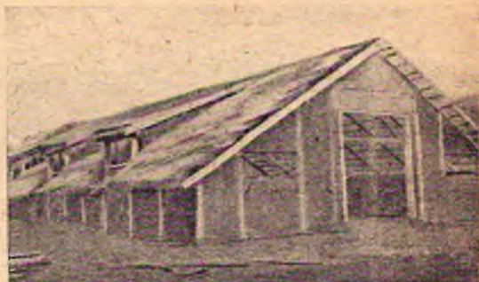
Покрытие крыши кошары камышом
