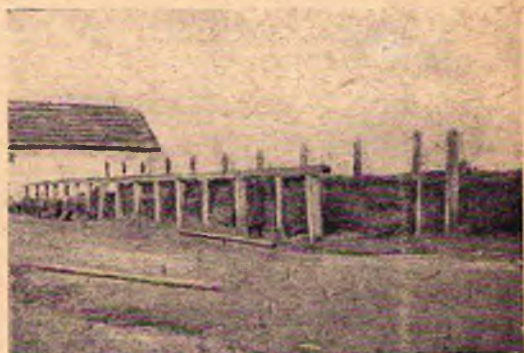
Постройка тепляка из пластов на хуторе «Красная звезда»
