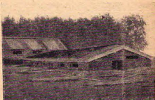
Постройка тепляка из пластов
