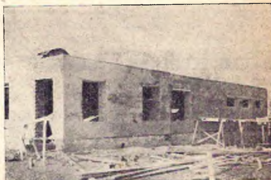
Постройка новой столовой, кухни и пекарни
