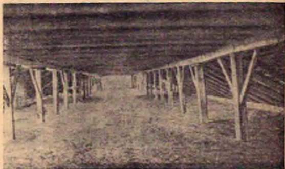
Внутренний вид кошары-крыши
