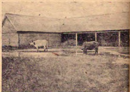
Неправильно выбранное место под строительство. Инвентарный сарай, залитый весенней водой (Баргойский совхоз, Вост. Сибирь)
