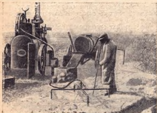
Рис. 9 ТРУБЫ ВВЕДЕННЫЕ В СИЛОСНУЮ ЯМУ.
