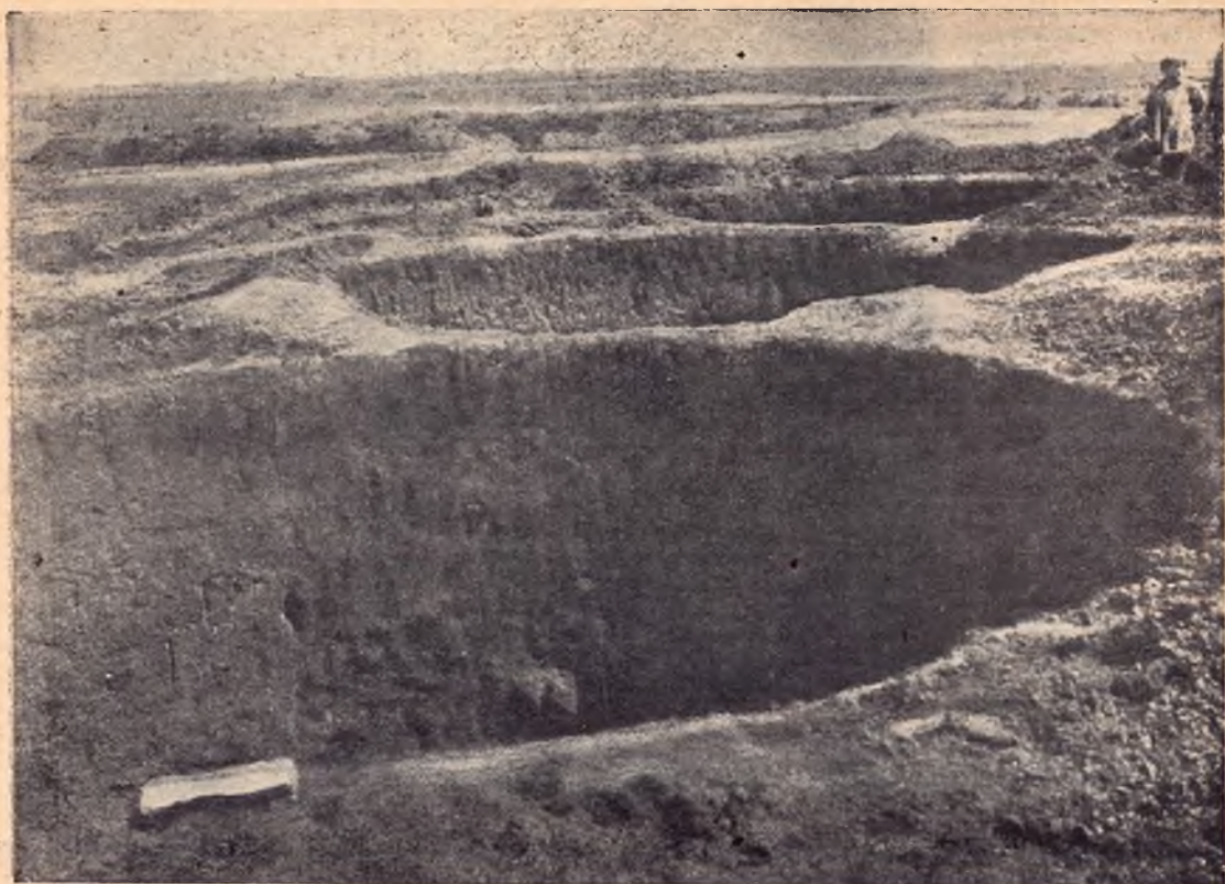
КОММУНА «АВАНГАРД» (ЗАПОРЖСКОГО ОКРУГА) РАЗВИВАЕТ СВИНОВОДСТВО. СЕЙЧАС КОММУНА ПРИСТУПИЛА К ПОСТРОЙКЕ СИЛОСНЫХ БАШЕН. НА СНИМКЕ КОТЛОВАНЫ-ЯМЫ СТРОЯЩЕГОСЯ ПОЛУБАШЕННОГО ТРЕХСТВОЛЬНОГО СИЛОСА.
