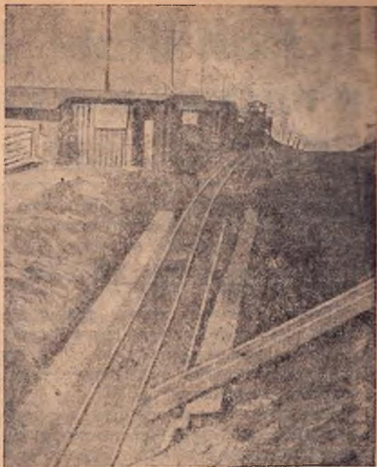
По обоим склонам горы в Леобшютце проложены рельсы. По этим рельсам при помощи электрической тяги двигаются вагоны, подвозящие корм и отвозящие навоз
