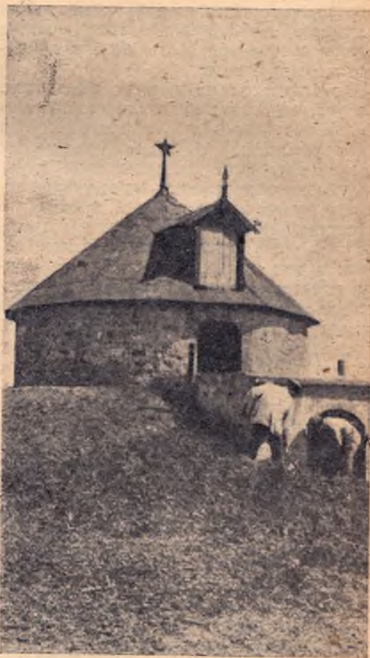
Коммуна им. Ап насенко (Минераловодский район). Силосная полубашня на 82 тонны, построенная ударником Хмыревым
