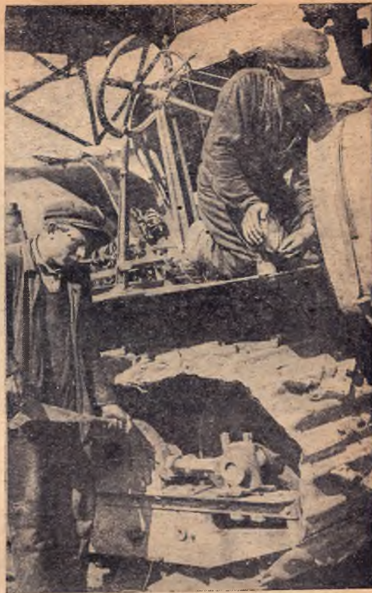
Племхоз «Венцы Заря» (Северный Кавказ). Ремонт трактора „Холт“
