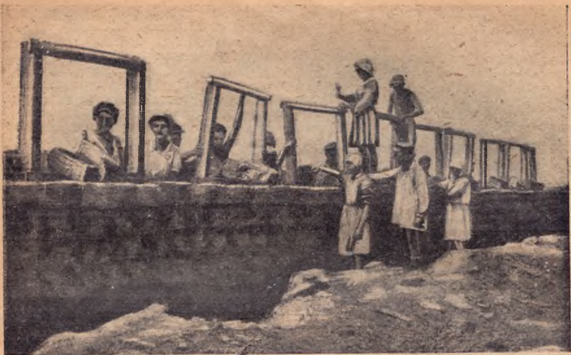
Совхоз № 22 (Северный Кавказ). Установка оконных коробок строящегося свинарника
