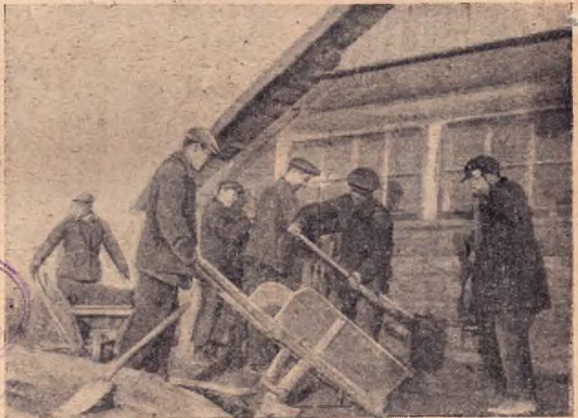
Утепление свинарника. Подсыпка земли и фундаменту
