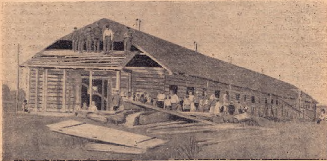
Строительство в колхозе «Комбайн» (Слуцкий район, БССР)
